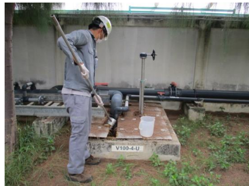
บ่อพักน้ำเสีย (Inspection Pit) (V100-4-U) ขนาด 1 ลบ.ม. (SW4)
